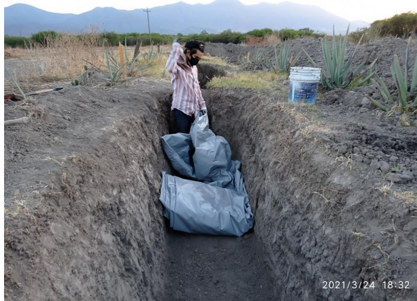
Anexo 13. Inflado de los biodigestores para su ubicación en el suelo.
