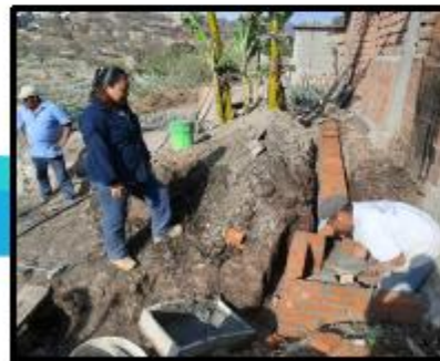
Construcción de canales de descarga de agua de tepache (vinaza)
