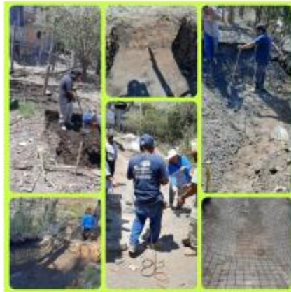
Preparación del terreno y construcción de la laguna
