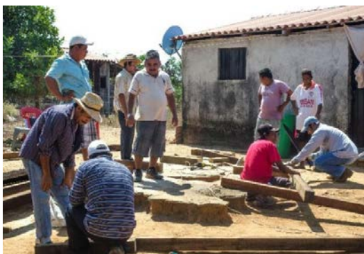
Fig. 4. Talleres de capacitación y de construcción
