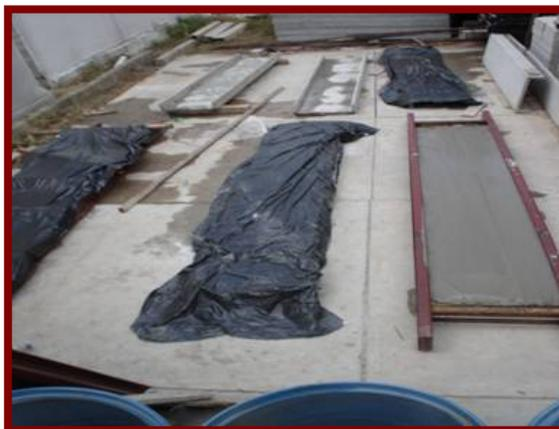
*Figura 36. Curado de piezas prefabricadas para evitar pérdida de humedad y prevenir agrietamiento por contracción.*
