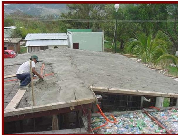
*Figura 49. Colado de la cubierta con mortero armado de 5 cm de espesor.*
