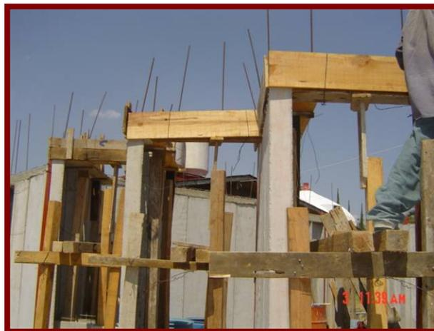
*Figura 44. Cimbrado y colado de la cadena de cerramiento.*
