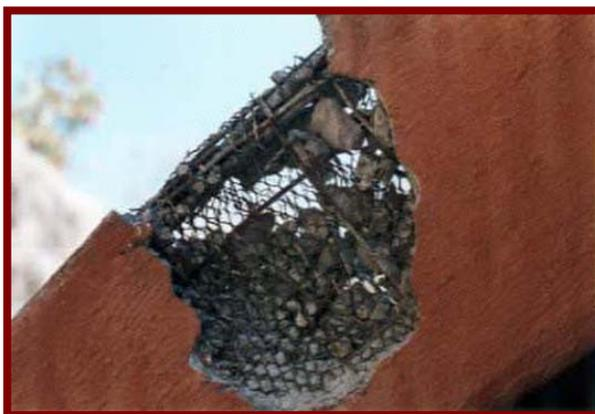
*Figura 1. Apariencia del ferrocemento.*
