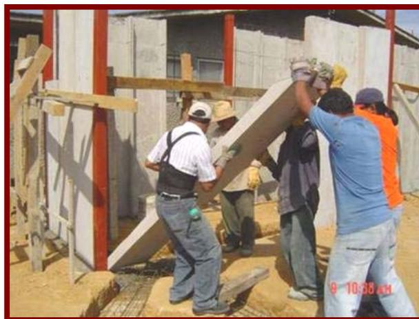
*Figura 42. Montaje de muros prefabricados de ferrocemento (Placa T1)*
