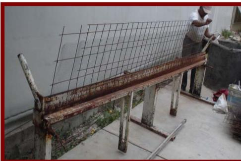
*Figura 34. Doblado del esqueleto metálico para la construcción de elementos muro.*
