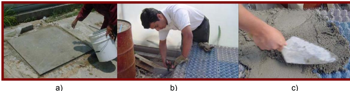
*Figura 25. Construcción de CM a) Construcción y curado de placas de ferrocemento, b) colocación de material aislante y malla de metal desplegado y c) aplicación de mortero hidráulico sobre el aislante térmico.*
