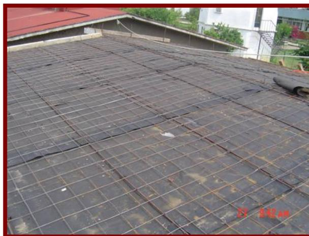
*Figura 48. Acero de refuerzo a base de malla electrosoldada y varillas de 3/8" a cada 90 cm en el claro corto.*
