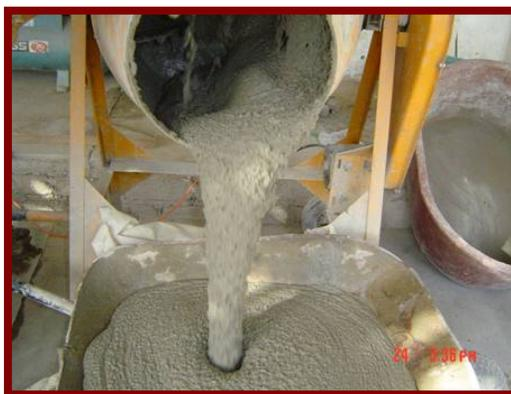
*Figura 35. Fabricación de mortero fluido para muros prefabricados.*
