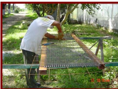
*Figura 33. Habilidad de acero para estructura de los elementos prefabricados.*
