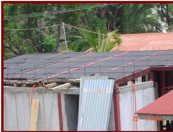
*Figura 47. Colocación de cartón asfáltico sobre conos de huevo.*
