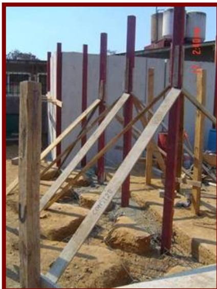
*Figura 41. Montaje de perfiles metálicos (PTR).*
