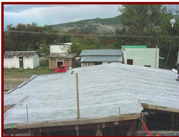
*Figura 50. Curado de losa con membrana y rociado de agua.*
