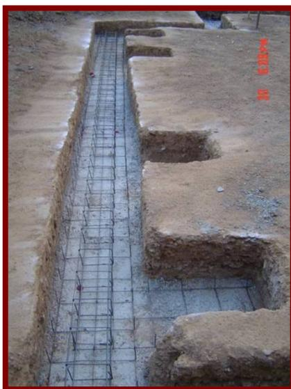
*Figura 40. Habilitado de acero de refuerzo para la cimentación.*
