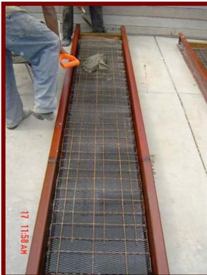
*Figura 10. Cimbra empleada en la fabricación de elementos muro.*
