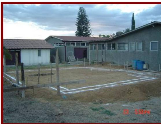
*Figura 38. Trazo y nivelación de terreno.*
