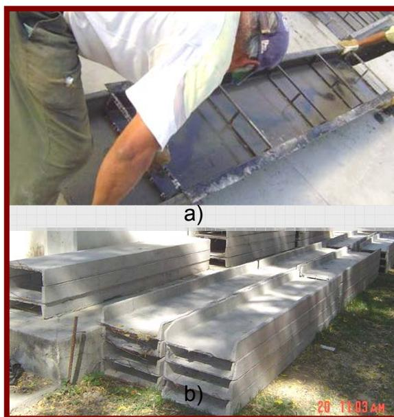
*Figura 37. a) Descimbrado de piezas prefabricadas, b) Estibación de piezas prefabricadas para continuar con su proceso de curado.*
