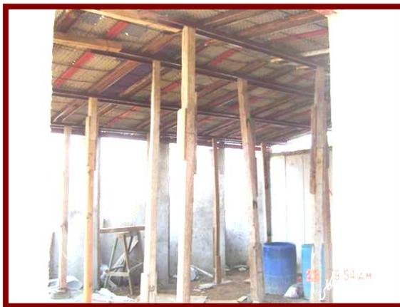
*Figura 46. Cimbrado de cubierta con conos de huevo.*
