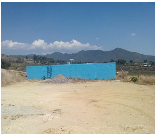
Figura 8: Tanque de distribución de agua potable en la localidad (construido en 2013).
