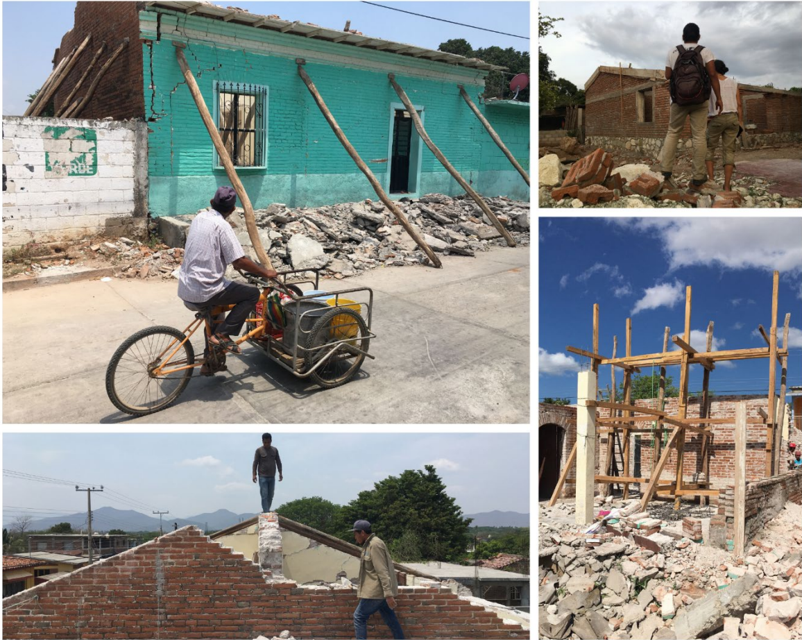
Figura 45 [Fotografías de German Parma]. (Ciudad Ixtepec, 2018). Estado de las viviendas después de los sismos de 2017.
