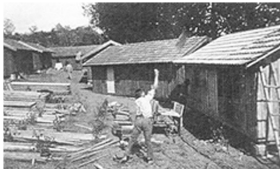
Figura 2. Casa de madera desmontable (Audefroy, 2009).
