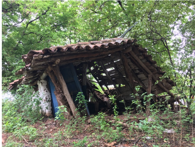
Figura 48 [Fotografía de German Parma]. (Ciudad Ixtepec, 2018). Vivienda de bajareque con cubierta de teja.
