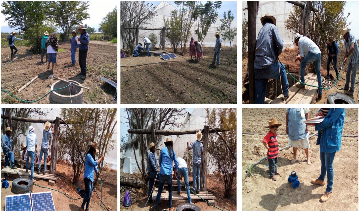
Figura 30. Instalación de los elementos para la puesta en marcha del sistema de bombeo solar, (2016).
