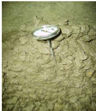
Figura 4. 5 Prueba de temperatura del concreto
