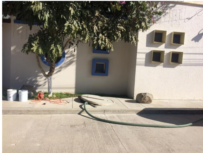
Figura 34. Pozo de absorción 11
