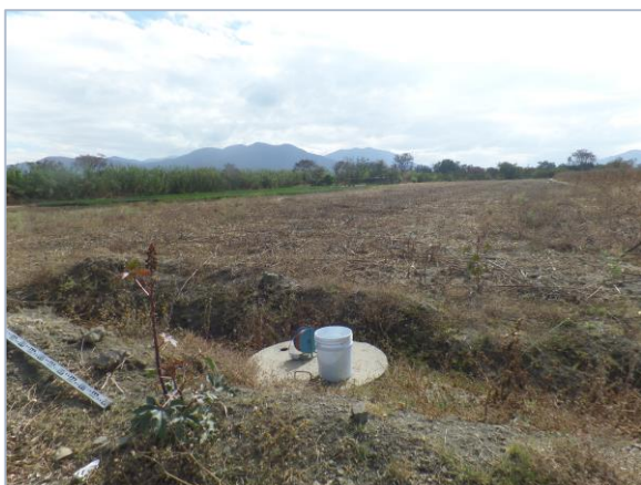
Figura 23. Pozo de absorción 3
