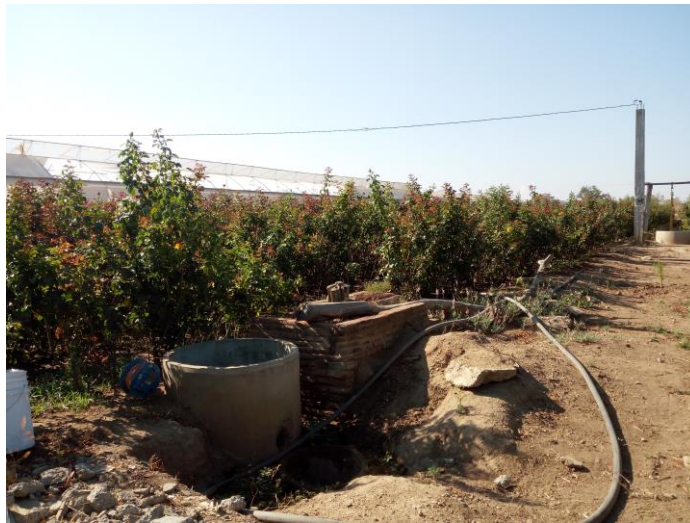
Figura 25. Pozo de absorción 4
