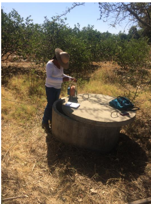
Figura 22. Pozo de absorción 2.
