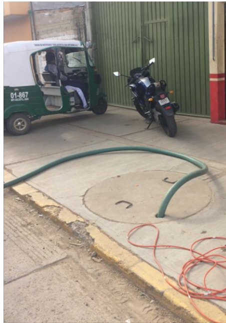
Figura 31. Pozo de absorción 9.
