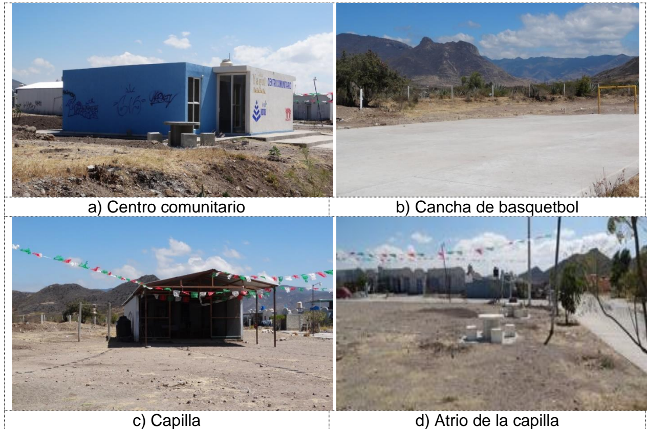
Figura 61. Reporte fotográfico del estado actual del predio *Fuente: Fotografías tomadas por el autor.
