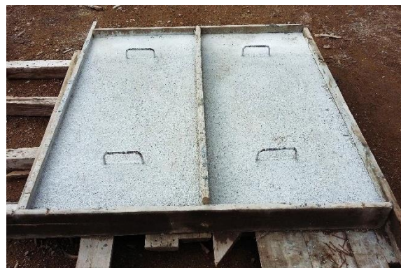
Figura 45. Elaboración de compuerta. Fotografía de Fredi Loaeza (2017).
