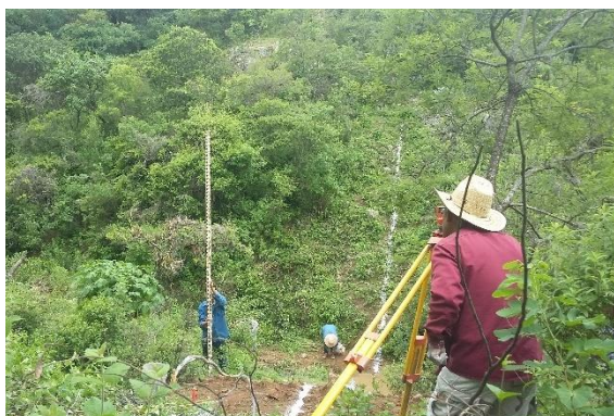
Figura 35. Trazo y nivelación con equipo topográfico.
