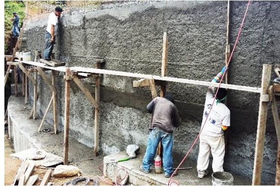
Figura 43. Aplanado de muro. Fotografía de Fredi Loaeza (2017).
