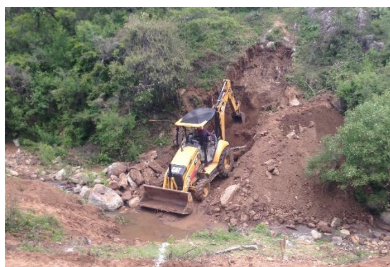
Figura 36. Excavación con medios mecánicos.
