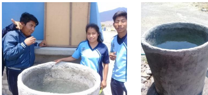
Figura 56. Tanque de ferrocemento elaborado por estudiantes del BIC No. 29. Fotografía de maestra Brenda García
