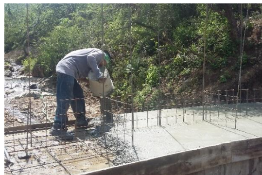
Figura 39. Elaboración de zapata corrida. Fotografía de Fredi Loeza (2017)
