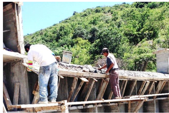
Figura 44. Colado de vertedor de demasías. Fotografía de Fredi Loaeza (2017).
