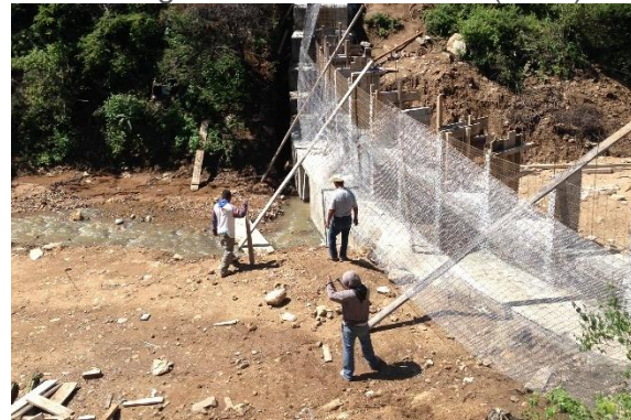
Figura 41. Colocación de mallas Fotografía de Fredi Loeza (2017)
