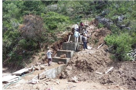
Figura 37. Cimentación de concreto ciclópeo. Fotografía de Fredi Loeza (2017)
