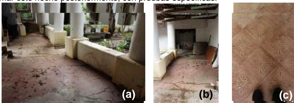
Figura 61. (a) y (b) Piso de pasillo de entrada con presencia de fisuras y hundimiento. (c) Patrón de piso de concreto. Fuente: DPCS
