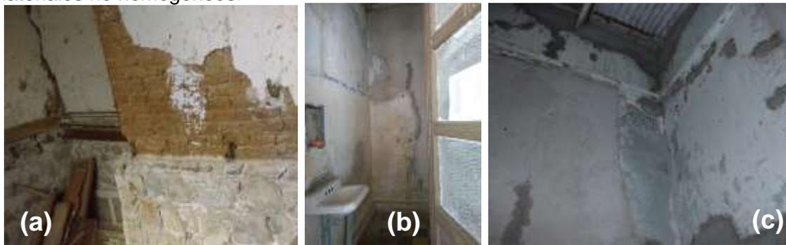
Figura 64. (a) exterior del muro del baño. (b) y (c) repellado con cemento en el interior.
