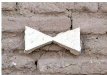
Figura 75. Testigo de yeso colocado en una fisura. Fuente: Carnevale, 2015.
