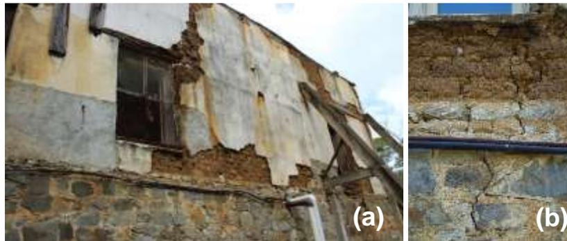
Figura 63. (a) Vista de muro oriente con contrafuertes. (b) fisura del sobrecimiento de piedra y del muro de adobe. Fuente: DPCS.
