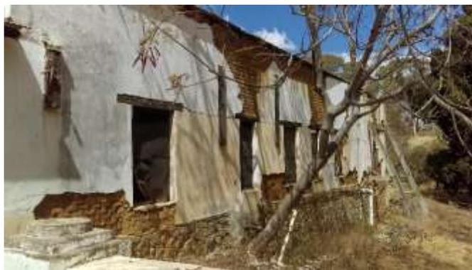
Figura 50. Fachada oriente con placas empotradas para los tensores. Fuente: DPCS.
