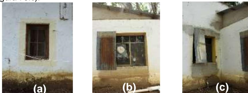
Figura 70. (a)Lesión de humedad por capilaridad en muros. (b)Error de diseño en alfeizar. (c)Intervenciones con cemento en dintel y alfeizar. Fuente: DPCS.
