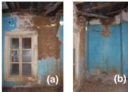
Figura 68. (a) La humedad en el muro fue generada por la cubierta del edificio. (b) Los elementos de soporte no son adecuados. Fuente: DPCS
