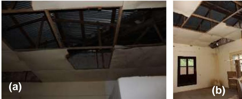
Figura 67. (a) Estructura improvisada con paneles faltantes. (b) Escurrimiento de material de adobe en los muros provocado por goteras. Fuente: DPCS.
