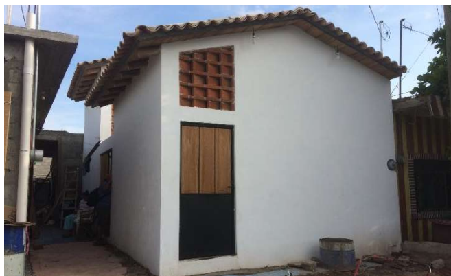
figura: 36 V4- Vivienda construida por Roots Studio con materiales de la región a base de tabique rojo, acero, concreto y cubierta con polines madera y tejas. Ubicada en Juchitán de Zaragoza Oaxaca. Foto: tomada por el autor.
