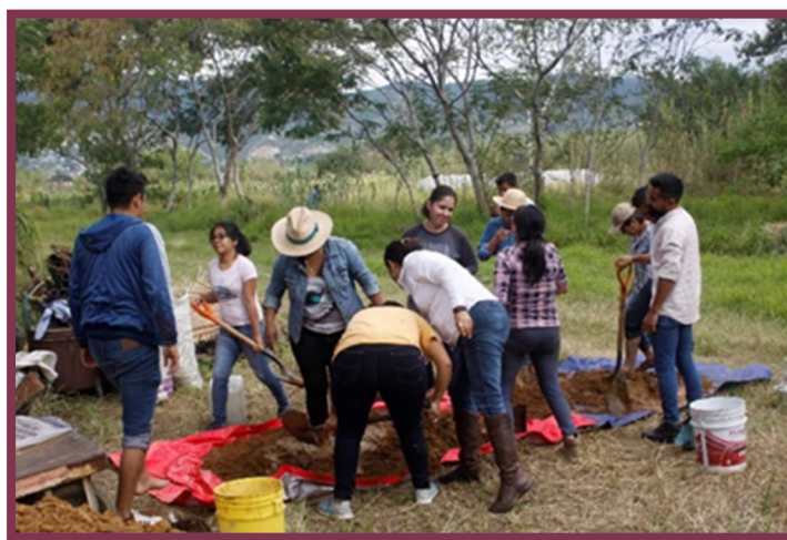
figura: 100 Amasado de la mezcla de tierra con los pies.
