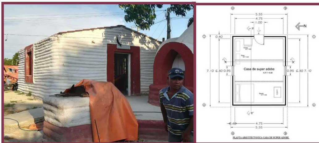
figura: 24 Vivienda implementada en el Istmo después de los sismos del 2017 con la técnica de Súper Adobe. Fuente: Joel Hernández.
