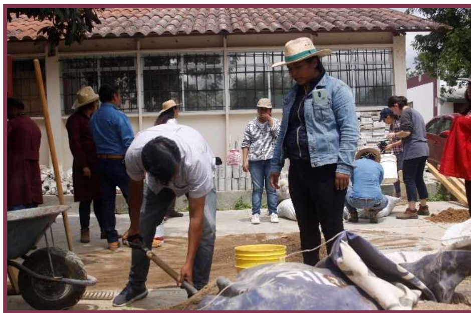
figura: 57 Caracterización de bancos de tierra para la construcción de muro de Bajareque
