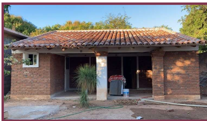
figura: 31 Vivienda implementada después de los sismos del 2017, en Ciudad Ixtepec, con materiales de la región. A base de tabique rojo, acero, cemento y cubierta de morillos, duelas y teja. Fuente: Tomadas por el autor, septiembre 2020.
