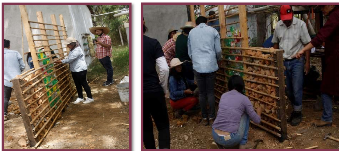
figura: 99 Trabajos para el relleno del muro con diferentes materiales.
