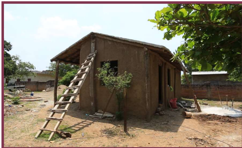
figura: 32 Vivienda construida después de los sismos del 2017 en Asunción Ixtaltepec, con sistema constructivo local "Bajareque" a base de materiales naturales como, madera, tierra, arena, Biliguana y tejas. Fuente: Tomadas por el autor, septiembre 2020
