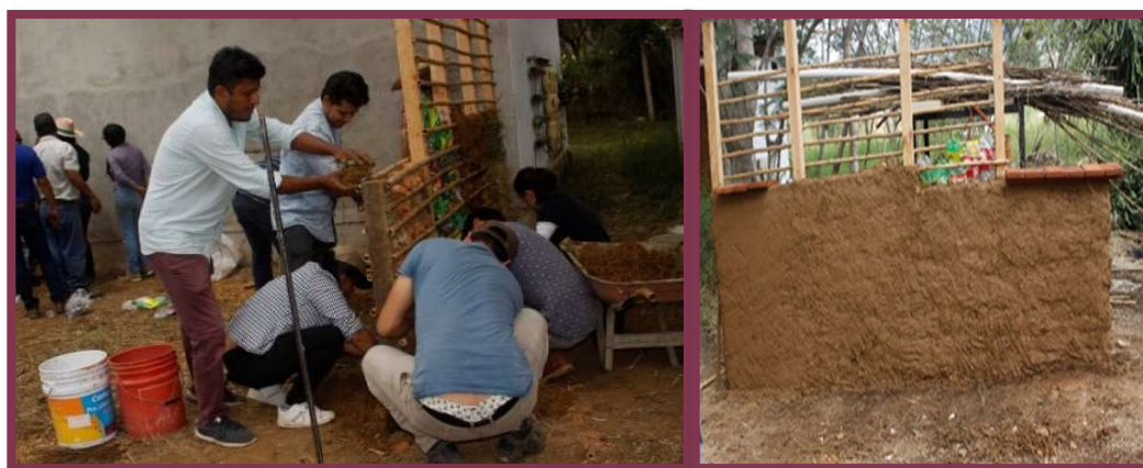
figura: 101 Aplicación de la mezcla de tierra de forma manual.
