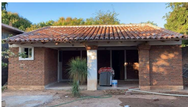
figura: 34 V2- Vivienda construida Cooperación Comunitaria con sistema tradicional de muro doble con tabique rojo en Ciudad Ixtepec. Foto: tomada por el autor.
