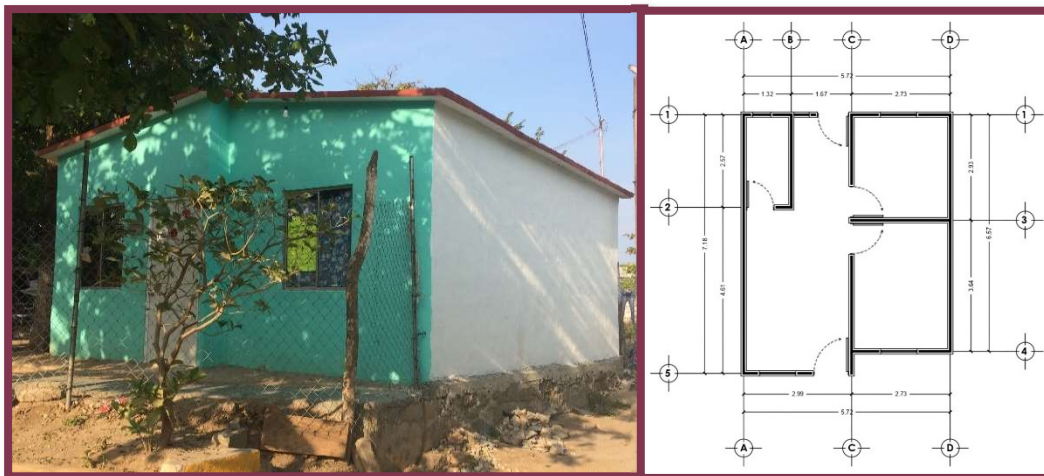
figura: 28 Vivienda implementada por Fundación Soriana en el Istmo de Tehuantepec después de los sismos del 2017, a base tabique sismo resistente y losa de concreto armado.
