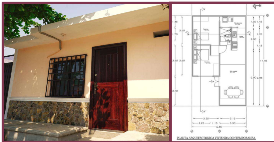
figura: 26 Vivienda contemporánea del Istmo de Tehuantepec, a base de tabique rojo, tabicón acero y cemento. Fuente: Joel Hernández
