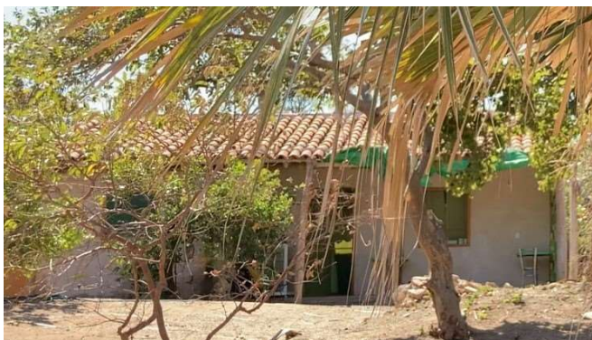
figura: 33 VI Vivienda construida por Eco Constructores con sistema constructivo "bajareque" en Asunción Ixtaltepec. Foto: Tomada por el autor.
