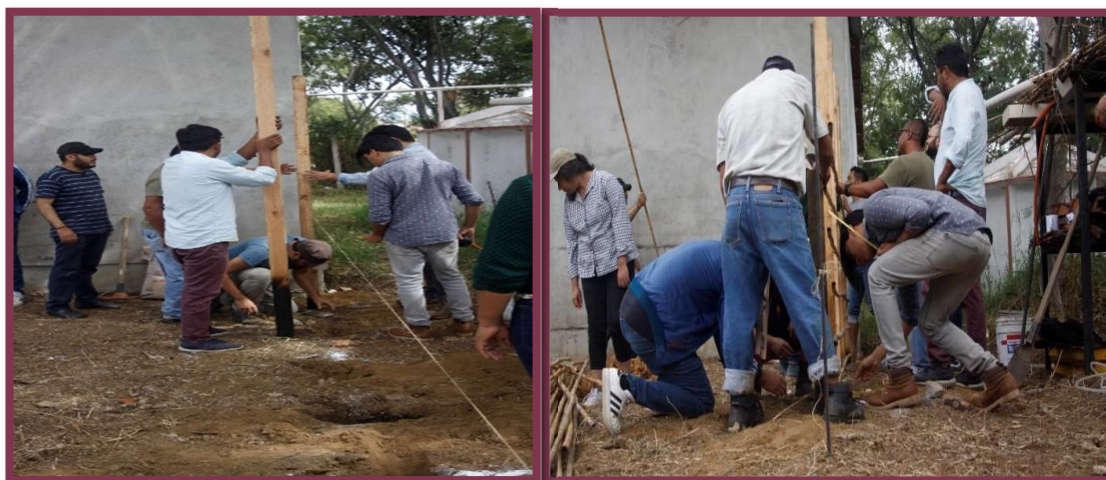
figura: 97 Trazo, nivelación y excavación para la construcción de muro. Fuente: Eugui Martínez Pérez (27/10/19)
