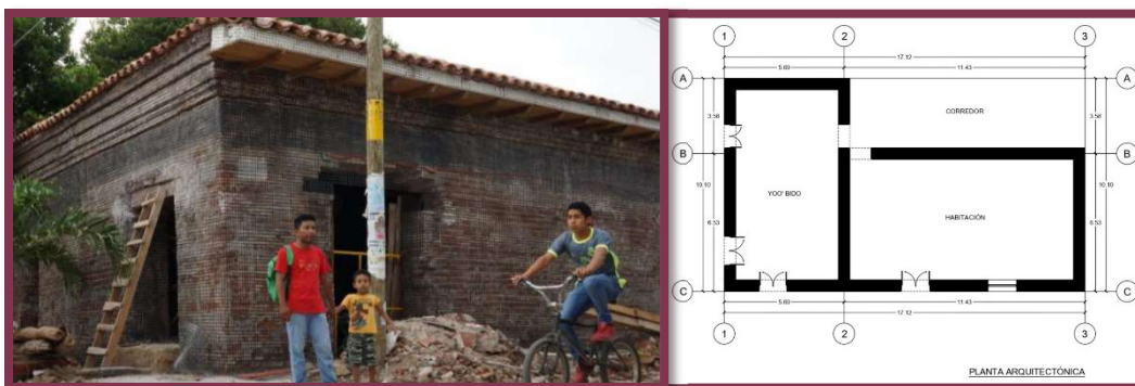
figura: 27 Vivienda tradicional de Juchitán de Zaragoza, Oax. Sistema constructivo tradicional a base de tabique rojo y cubierta de biliguanas, morillos y tejas.
