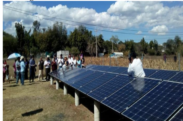
Instalación de los paneles solares dentro de la agencia de Santa María Xochitlapilco
