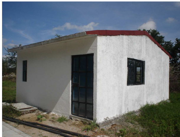
Figura 24. Prototipo de vivienda económica de paneles modulares de ferrocemento.
