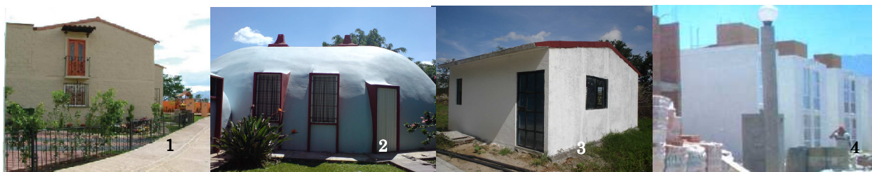
Figura. 26 Sistemas constructivos analizados (1-Muros de bloque de concreto y cubierta de casetón de polietileno, 2- muros y cubierta de ferrocemento in situ, 3- muros y cubierta de paneles modulares de ferrocemento, 4-muros de ladrillo y cubierta de concreto armado).
