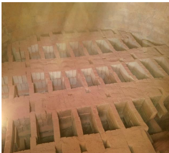
Figura 18. Acomodo de ladrillos en el nivel E
