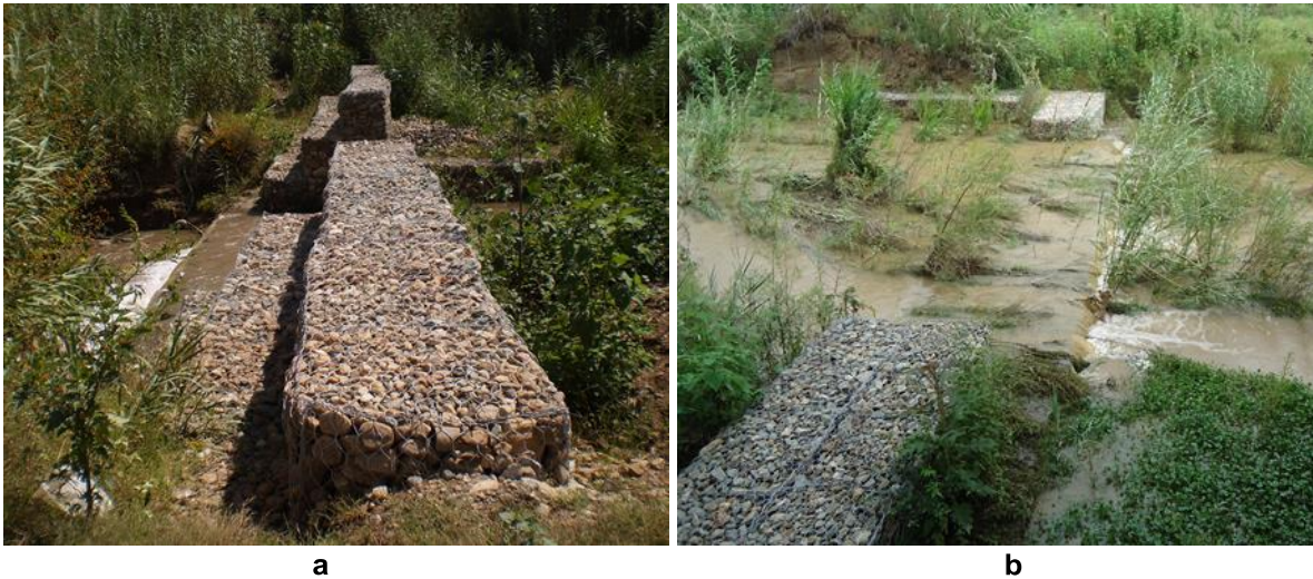
Figura 2. Presas de gaviones en el río Zautla: a) Presa 1; b) Presa 2
