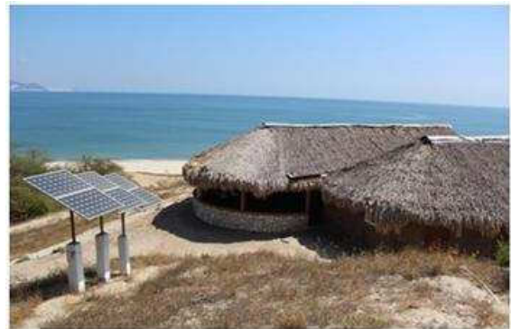
Uso de energía renovable (paneles solares)
