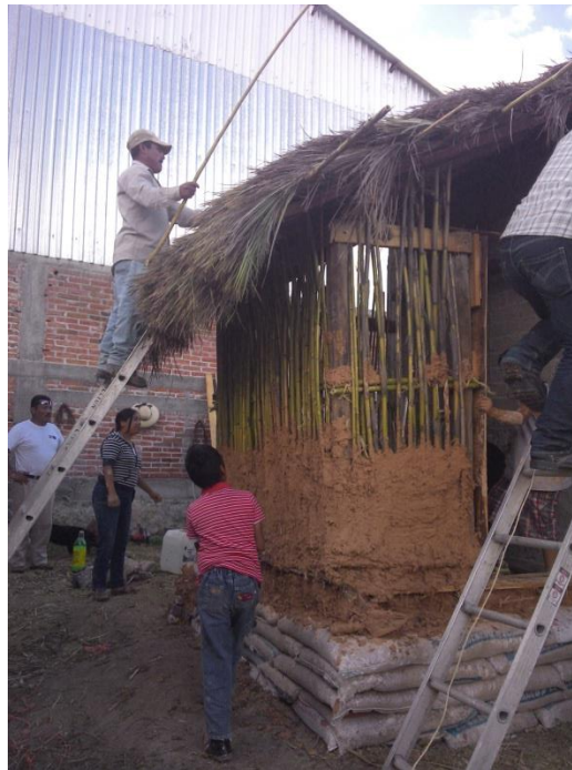
Figura 3.17 Proceso constructivo del baño seco. Fuente propia. Fotografía del 10.10.2014
