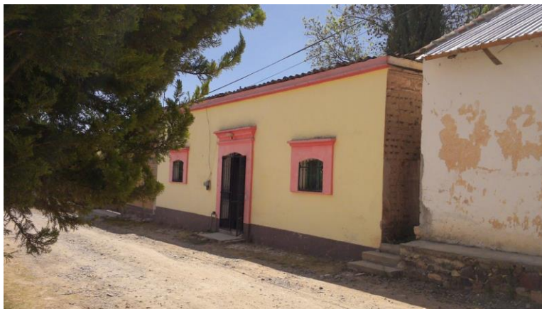
Figura 3.5 Fachada de la vivienda vernácula. Fuente propia. Fotografía del 15 de febrero de 2014.
