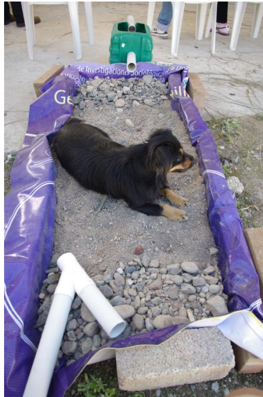
Figura 3.18 Biofiltro para tratamiento de aguas grises. Fuente propia. Fotografía del 05.10.2015
