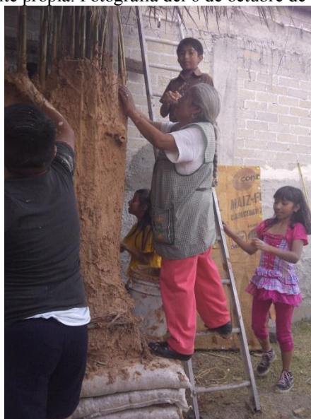
Figura 3.29 Aplicación de la mezcla de lodo y paja para un muro de bahareque. Fuente propia. Fotografía del 10 de octubre de 2014.
