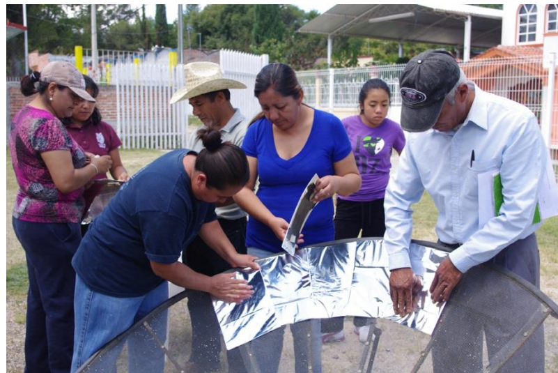
Figura 3.19 Proceso constructivo de la estufa solar. Fuente. Elaboración propia. Fotografía del 11.10.2015.
