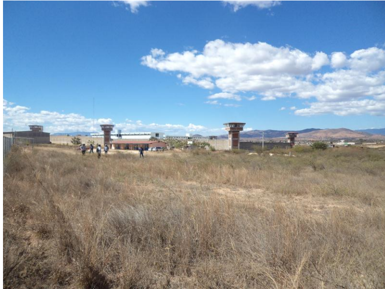
Figura 19. Primera visita de campo, el terreno Fuente: Tomada por el autor
