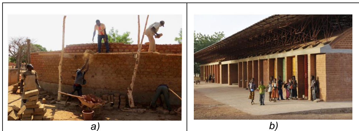
Figura 1. Escuela en Burkina Faso: a) Sistema constructivo y b) Proyecto culminado Fuente: Nsé (2012)
