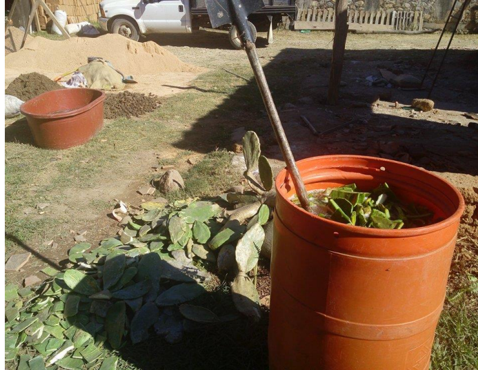
Figura 47: Mejoramiento de la tierra a base de baba de nopal. Fuente: Foto tomada por el autor
