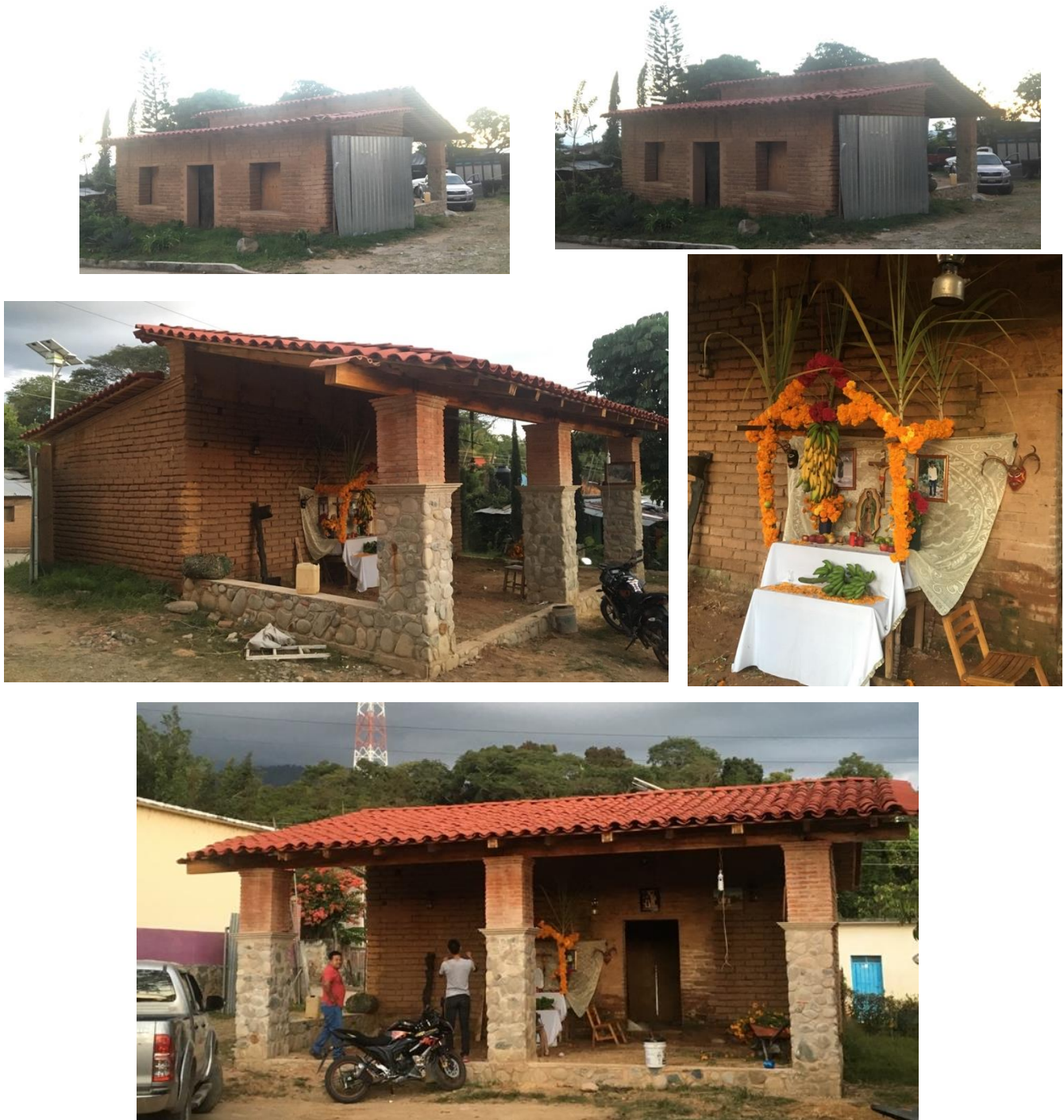
Figura 50: Etapa terminal en la intervención de la vivienda vernácula Fuente: Fotos tomadas por el autor
