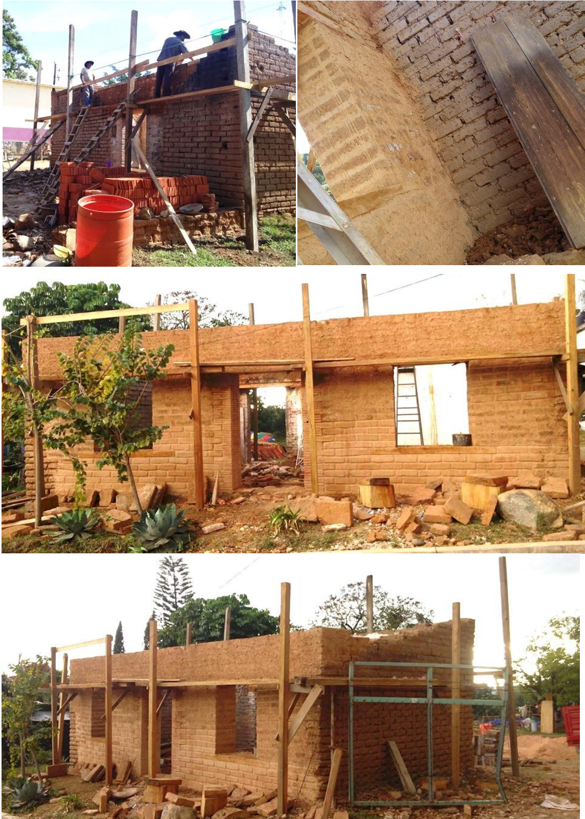
Figura 49: Avances en la intervención de la vivienda vernácula.
