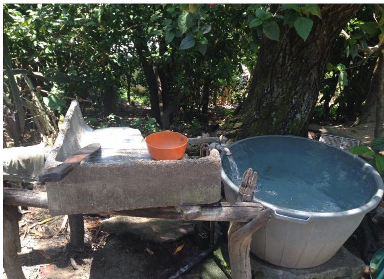
Estanque y Lavadero
