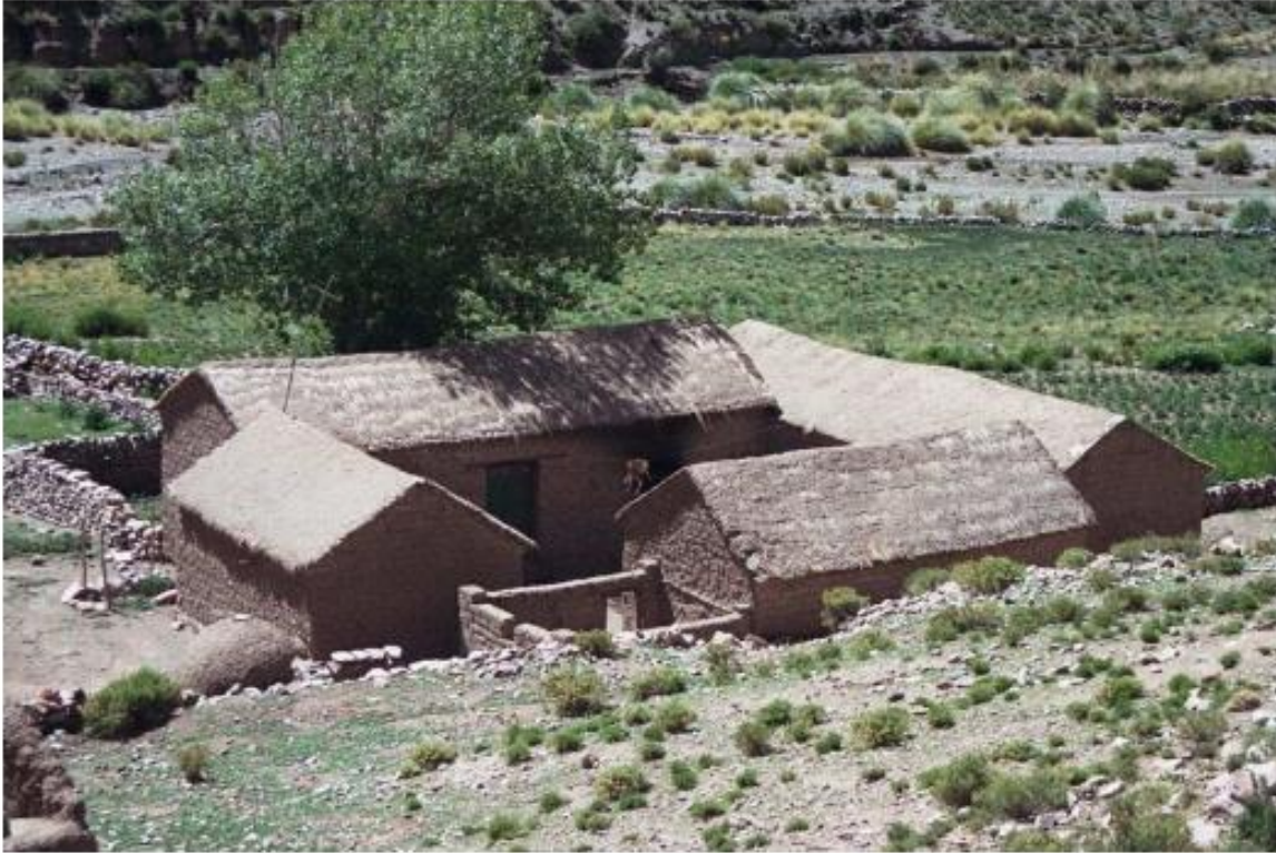
Figura 2: Vivienda rural segura y saludable, construida mediante la autoconstrucción y mano de obra local. Perú, Lima. Fuente: (Fuentes, 2007)
