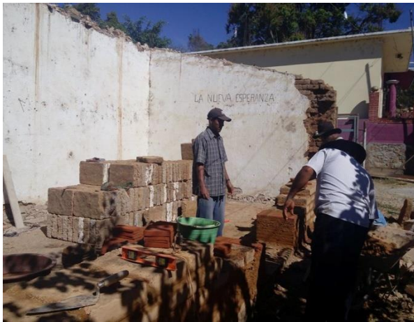
Figura 45: Demolición de muros en mal estado Fuente: Foto tomada por el autor
