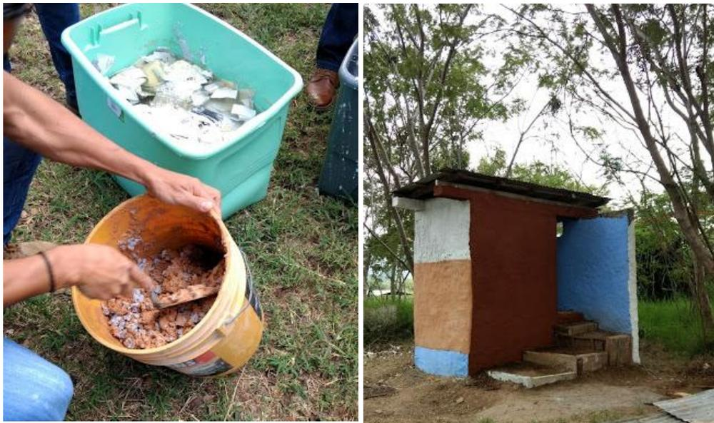
Figura 24. Elaboración de la pasta hecha con base en papel reciclado y Vista del aplanado final en un muro. Septiembre 2018.
